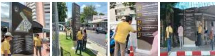
๕. วันจันทร์ที่ ๙ กันยายน ๒๕๖๗ งานโยธาและสถาปัตย์โดยคณะกรรมการตรวจรับพัสดุและผู้ควบคุมงานจ้างจัดทำพร้อมติดตั้งป้ายชื่ออาคารฯ ตามสัญญาจ้างเลขที่ ๗/๒๕๖๗ ลงวันที่ ๑๒ กรกฎาคม ๒๕๖๗ ได้ดำเนินการตรวจสอบความแข็งแรงในการยึดติดป้ายชื่ออาคารที่ติดตั้งภายในมหาวิทยาลัย เพื่อให้การดำเนินงานเป็นไปตามแบบรูปรายการที่กำหนดในสัญญาต่อไป
